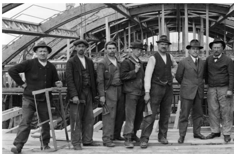
Baustelle Mustermesse, 1924. Foto Hoffmann, Basel. Staatsarchiv Basel-Stadt
